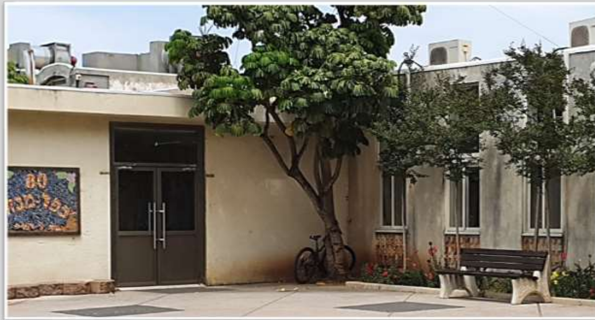
הכניסה לחדר האוכל. אריחי הקרמיקה מתחת לחלונות הם מעשה ידיו של משה סעידי
